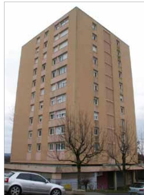
La tour, 2 rue des Vosges, démolie début 2013
